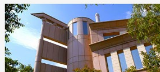
Building 3 - Av. Esplugues
